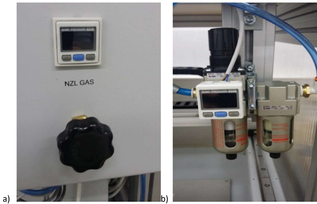
Obr. 5: Regulace tlaku vzduchu
